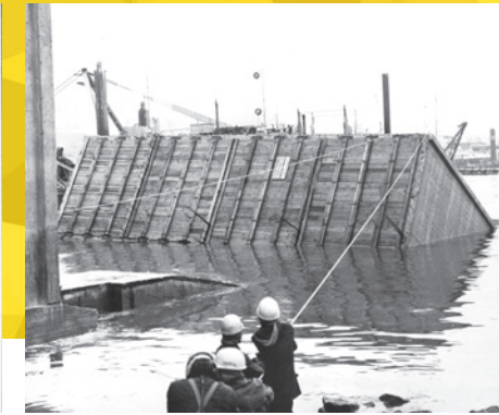
Kasuuni on laskettu veteen Hietasen sataman rakennusvaiheessa. HKS
